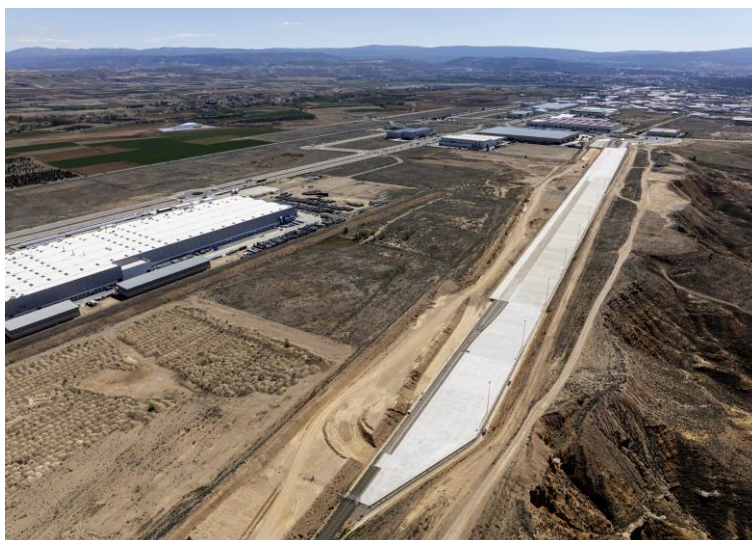
Infraestructura ferroviaria en PLATEA
