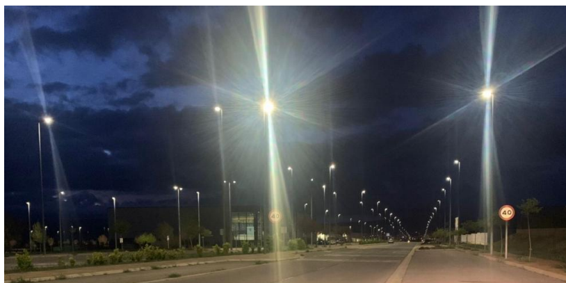
Renovación del alumbrado en PLATEA
